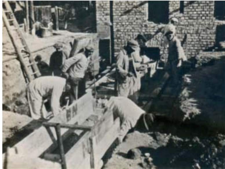
Handwerker arbeiten an den Fundamenten
