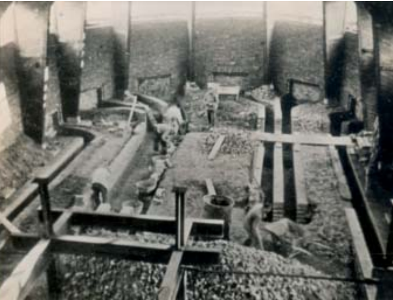
Bau der Heizungskanäle im Fußboden des Kirchenschiffs
